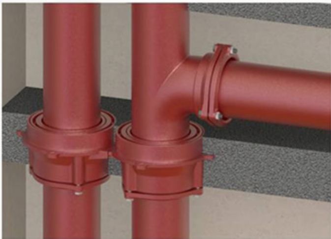
1、安装完成的管道。
